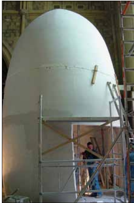
■ Freiform-Objekt im Bau
